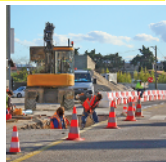
Las obras Roadwork/work zone
