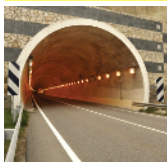
El túnel Tunnel
