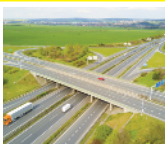
La intersección de autopistas Highway interchange/junction
