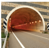
der Tunnel the tunnel
