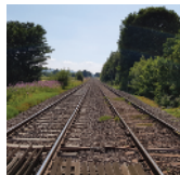
Voie (ferrée) (Railway) track
