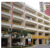
Parking à étages Multi-story car park
