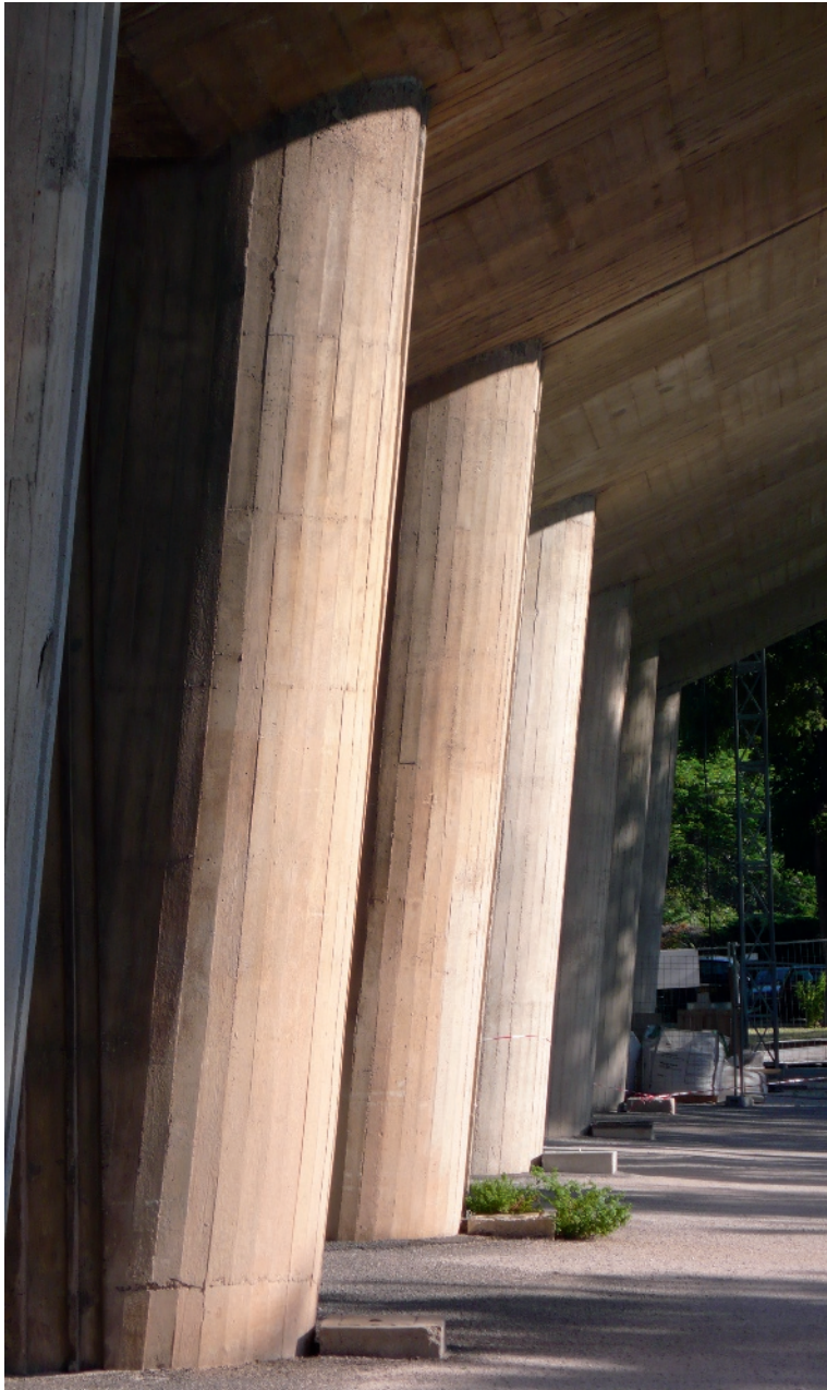
Le Corbusier, Unité d'Habitation of Marseille, 1952.
