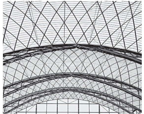
Bild 1.15 Blick auf die Tragstruktur
