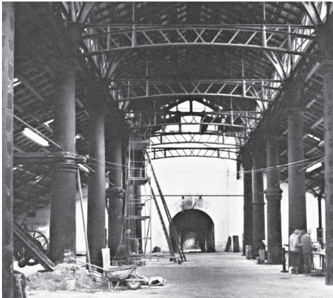
Bild 1.18 Sayner Gießhalle – Blick in das Mittelschiff [1.17]
