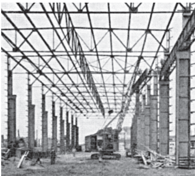
Bild 1.19 Hallenkonstruktion mit Vollwandstützen [1.18]
